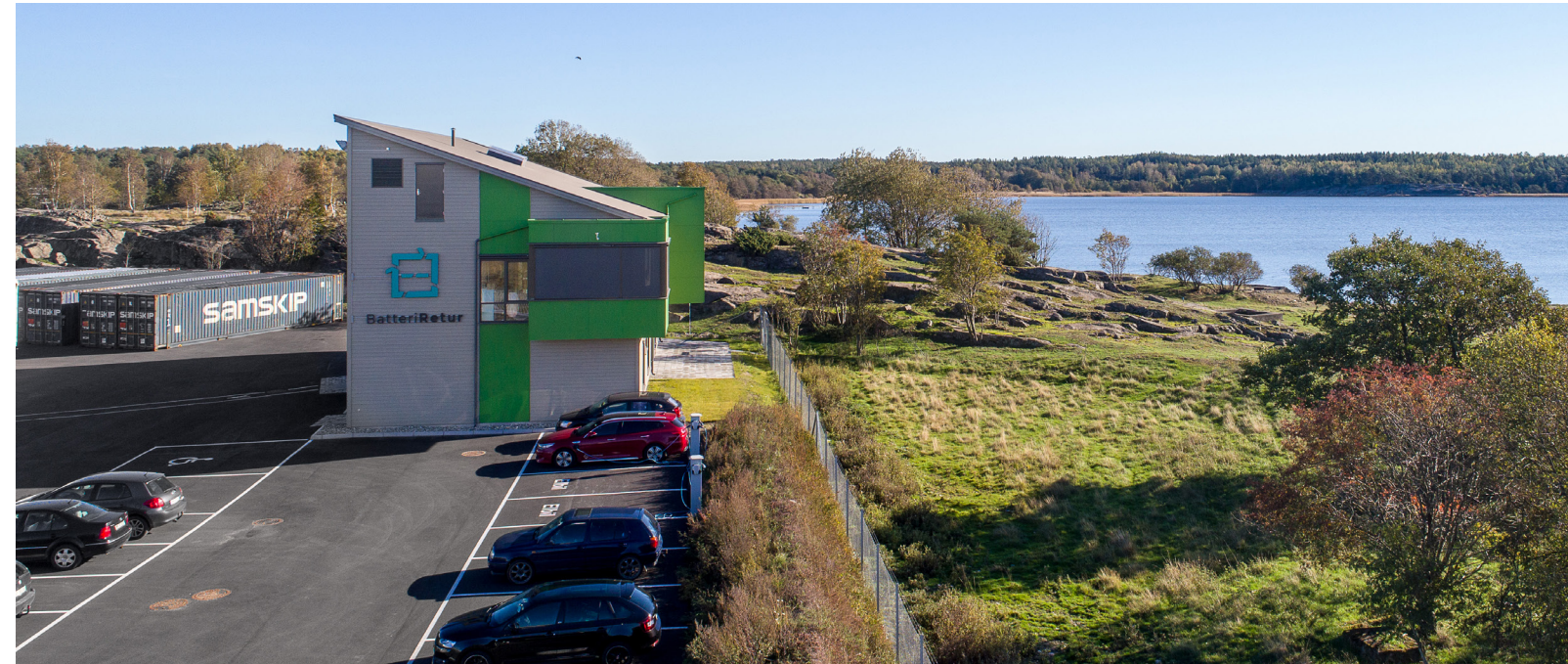
På bildet: Midt i bildet ser vi Batteriretur, sentralt beliggende på Øra Industriområde utenfor Fredrikstad.
